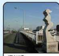
横川橋 水・風・緑・空をテーマにした彫刻が4基設置されています。
